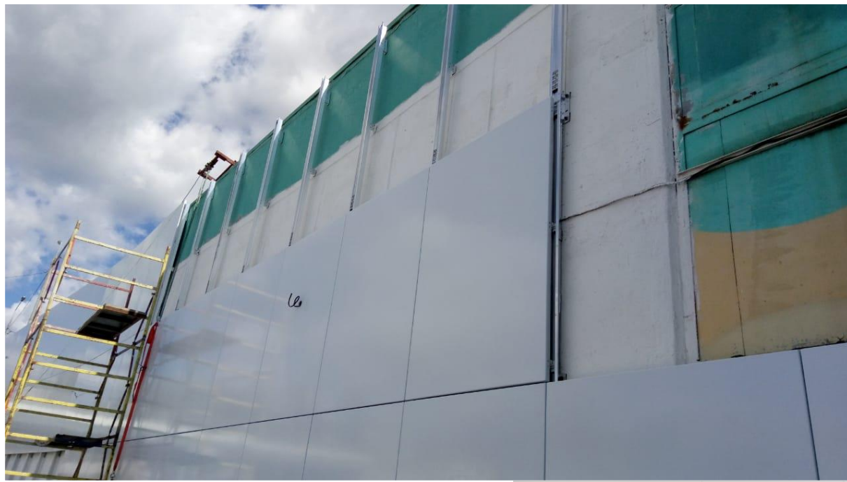
Автодорожный тоннель, г. Сергиев Посад, Московская обл.
